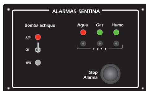
3- Alarma de Inundación El nivel de agua ha subido. Se activa alarma acústica de inundación
